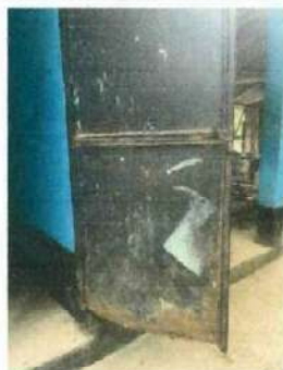
Foto 5: MANTENIMIENTO A PUERTAS DE BAÑOS
