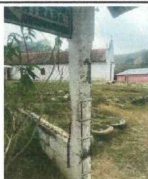
Foto 4: REPARACION DE ESTRUCTURA PARA CERCO
