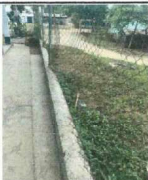
Foto 3: MEJORAMIENTO A CERCO PERIMETRAL
