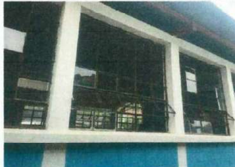
Foto 6: CAMBIO DE VIDRIOS
