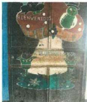
Foto 2: MANTENIMIENTO A PUERTAS
